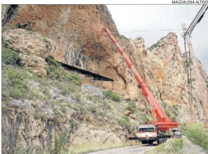
Una grua instal·la la coberta al jaciment de la Roca dels Bous.
