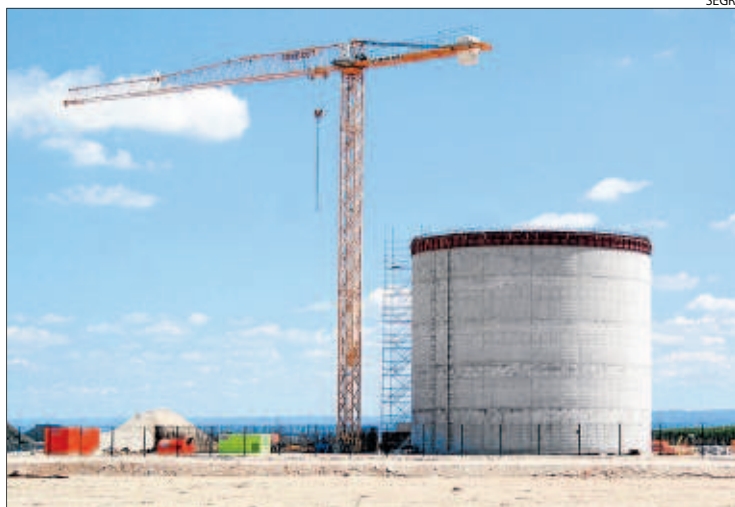
Imatge recent de la planta en construcció a Miralcamp.
