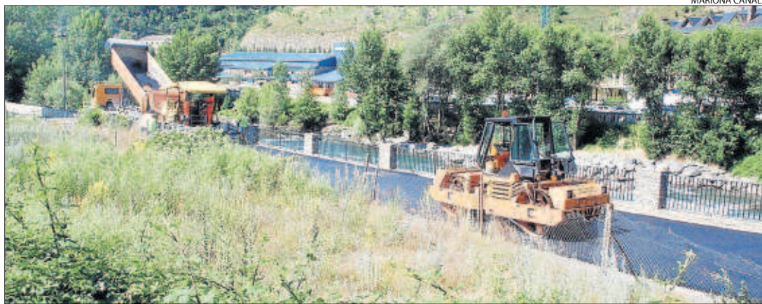
Imatge de les obres portades a terme a la carretera que surt de la Nacional a Sort, al costat del riu.
