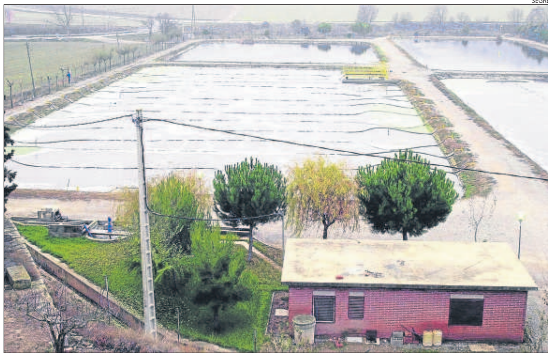
Imatge d'arxiu de la depuradora d'aigües residuals de Cervera.
