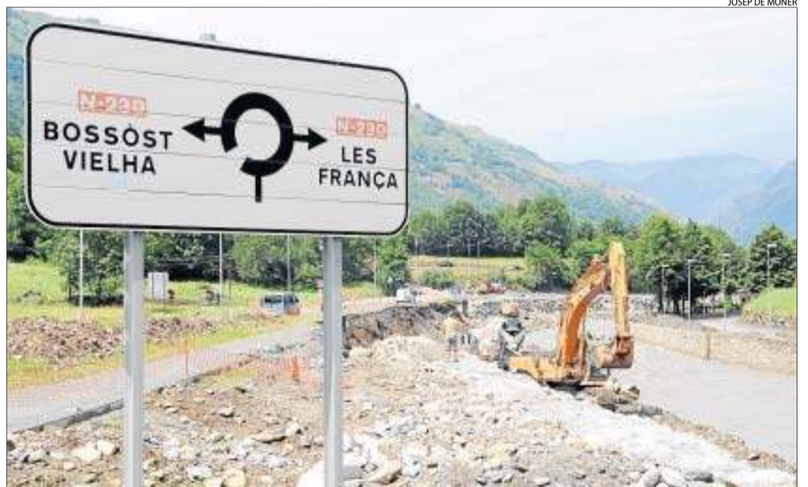
Els treballs, ahir, per restablir la carretera N-230 entre Bossòst i Les.
